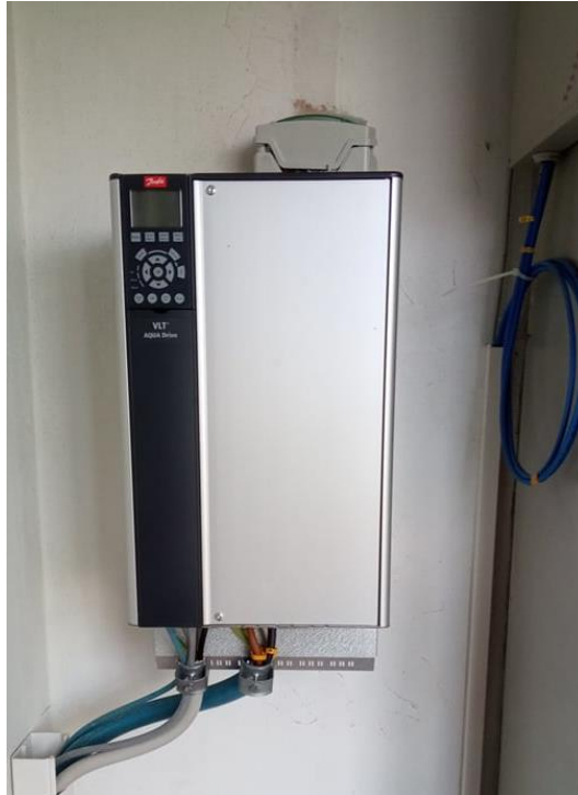
Sl. 4.10. Danfos frekvencijski pretvarač
