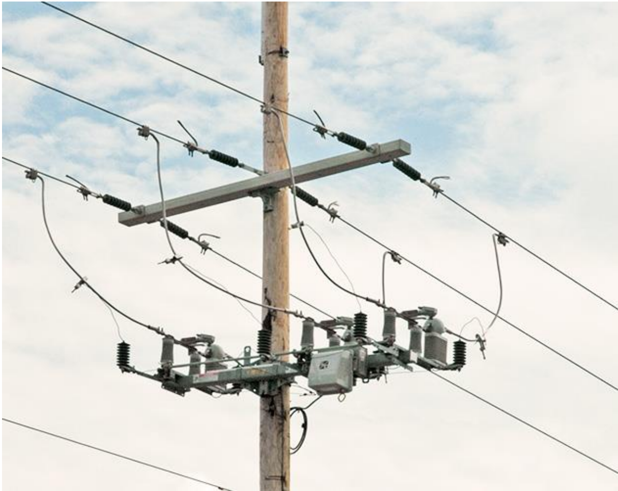
Slika 5.6. Automatski prekidač [16]
