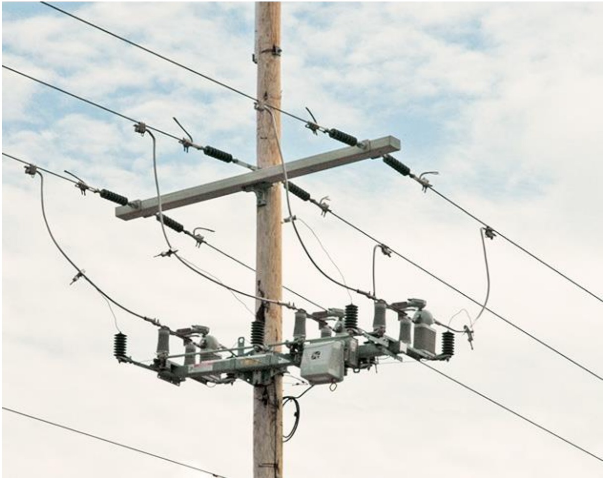
Slika 5.6. Automatski prekidač [16]
