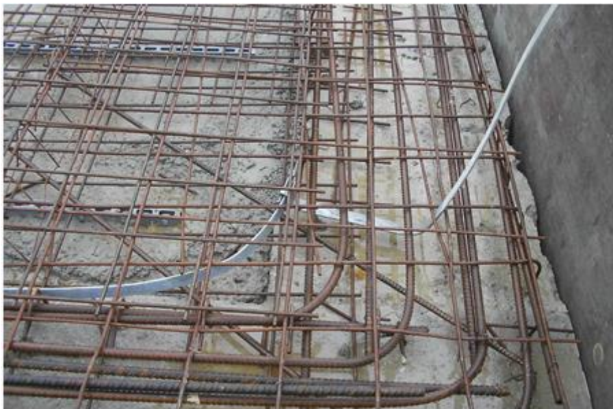
Slika 5.10 Temeljni uzemljivač [5]
