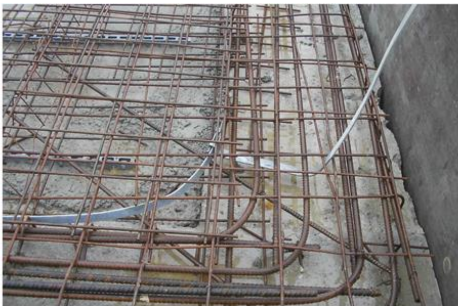
Slika 5.10 Temeljni uzemljivač [5]
