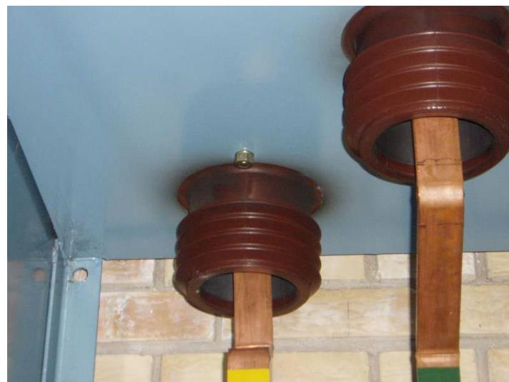
**Slika 7.13.** Vidljive promjene u boji limova uz prolazne izolatore na provodnim pločama
