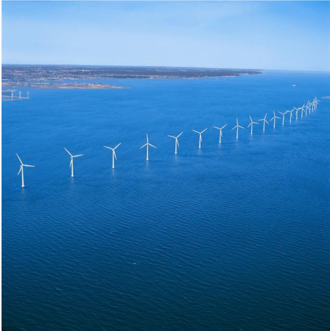
Slika 1.1. Priobalna vjetroelektrana Greater Gabbard [2]
