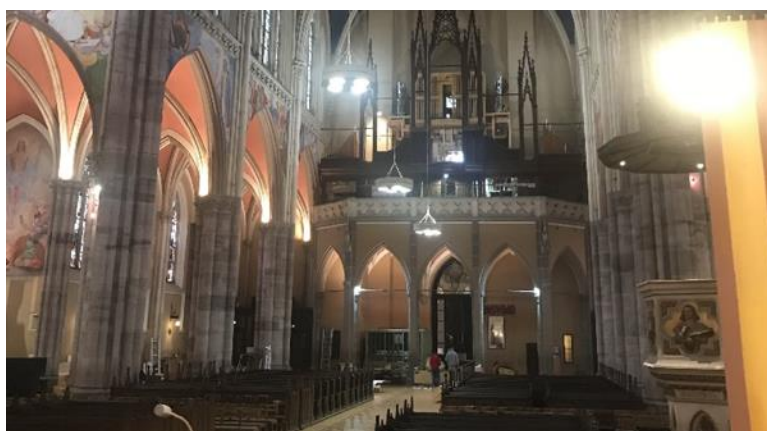
Slika 6.1 Postojeća rasvjeta (pogled na središnji prostor s glavnog oltara)
