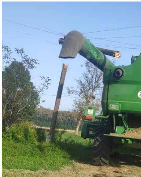
Slika 1.1. Oštećenje nosivog stupa električnog voda ljudskim faktorom
