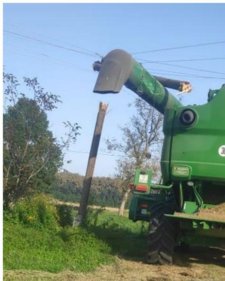
Slika 1.1. Oštećenje nosivog stupa električnog voda ljudskim faktorom
