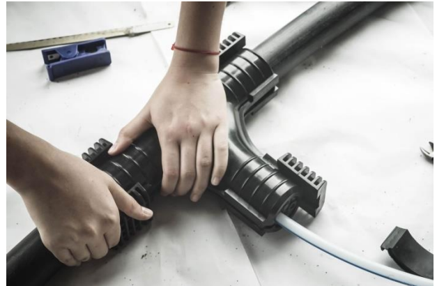
Slika 5.19: Zatvaranje T konektora
