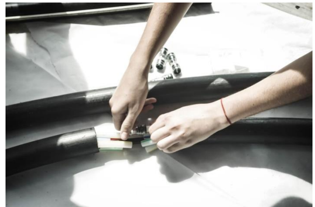
Slika 5.6: Spajanje mikrocijevi konektorima za mikrocijevi
