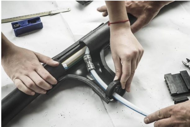
Slika 5.18: Postavljanje brtve na kraj T konektora za
