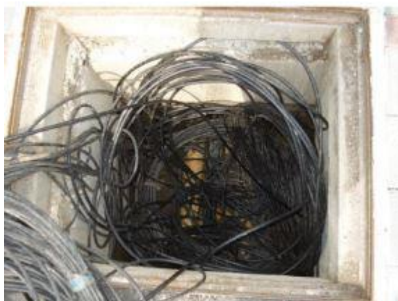
Slika 3.2: Stvarno stanje kabelske kanalizacije, [13]
