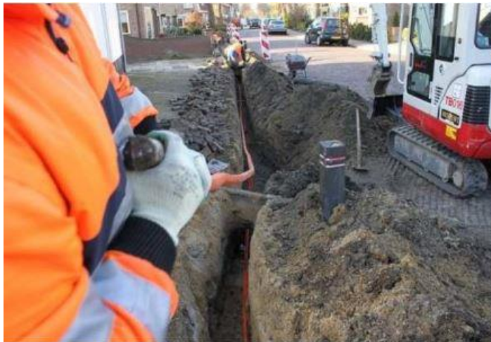
Slika 4.21: Polaganje mikrocijevne strukture [25]
