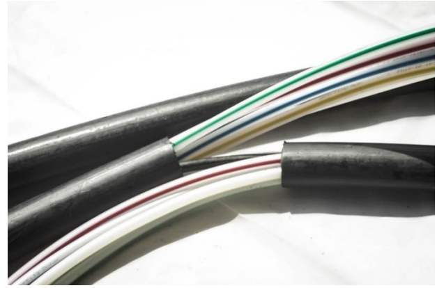
Slika 5.4: Snopovi mikrocijevi uvučeni u jednu i drugu stranu cijevi na odrezanom dijelu cijevi
