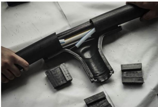
Slika 5.16: Postavljanje T konektora
