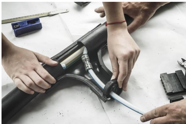
Slika 5.18: Postavljanje brtve na kraj T konektora za
