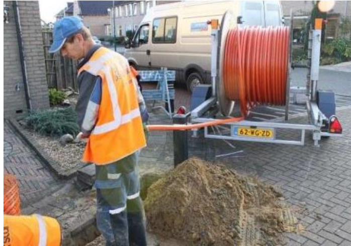
Slika 4.20: Odmotavanje mikrocijevne strukture [25]
