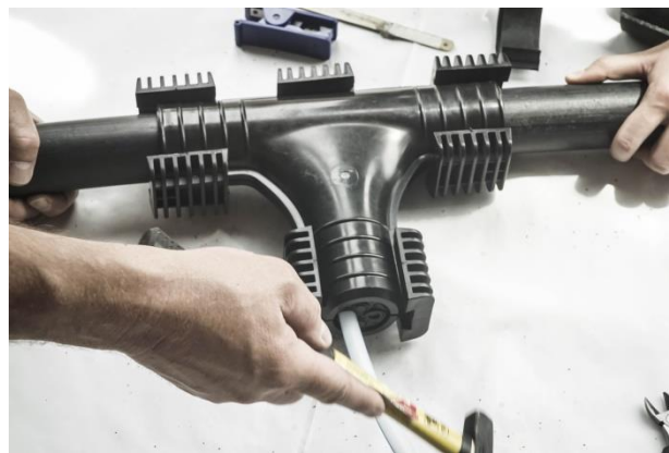
Slika 5.20: Reparirana PE50 cijev
