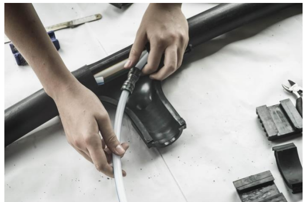
Slika 5.17: Spajanje mikrocijevi konektorom za mikrocijevi
