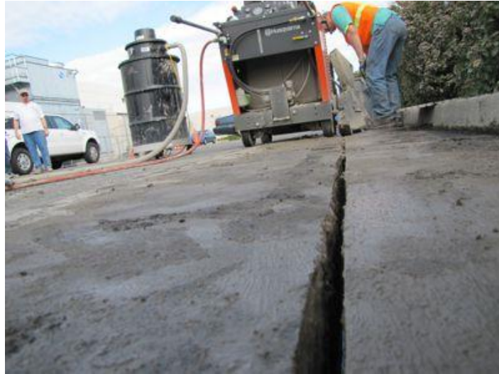
Slika 4.23: Microtrenching , [27]
