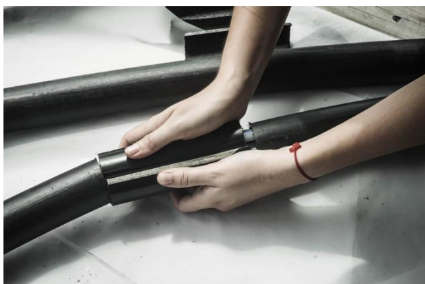
Slika 5.9: Postavljanje reparaturne sklopive cijevi
