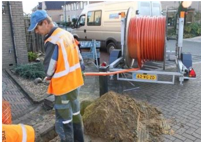
Slika 4.20: Odmotavanje mikrocijevne strukture [25]
