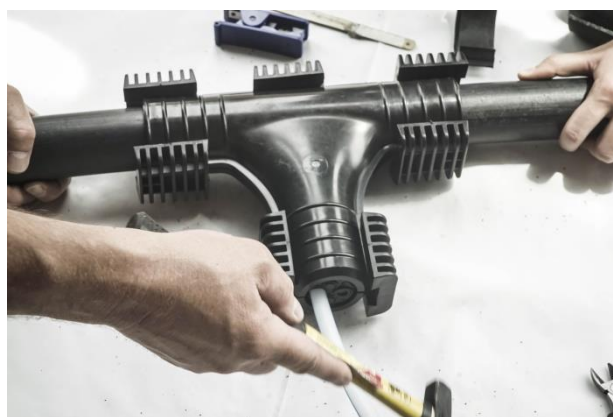
Slika 5.20: Reparirana PE50 cijev
