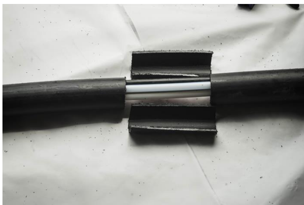
Slika 5.14: Odrezani dio PE50 cijevi s mikrocijevima
