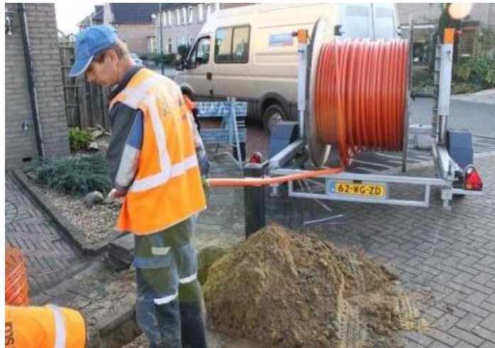
Slika 4.20: Odmotavanje mikrocijevne strukture [25]
