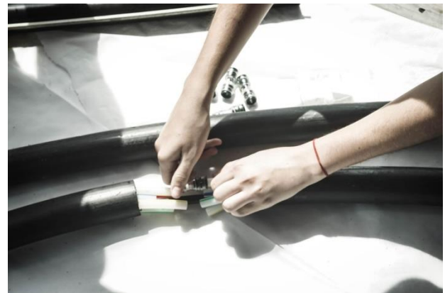
Slika 5.6: Spajanje mikrocijevi konektorima za mikrocijevi
