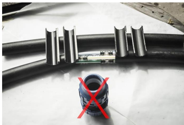
Slika 5.8: Reparacija cijevi isključivo reparaturnim kompletom
