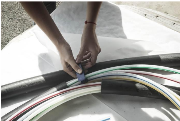
Slika 5.5: Skraćivanje mikrocijevi
