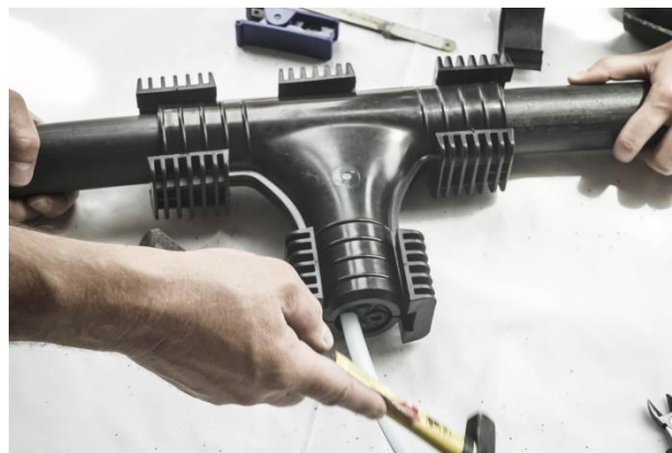
Slika 5.20: Reparirana PE50 cijev
