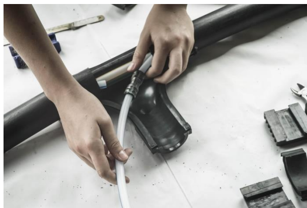
Slika 5.17: Spajanje mikrocijevi konektorom za mikrocijevi
