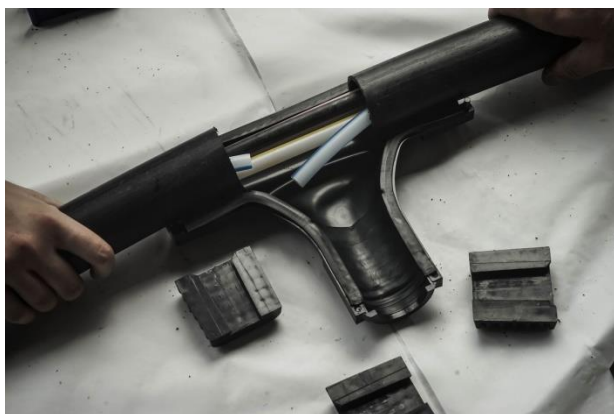
Slika 5.16: Postavljanje T konektora
