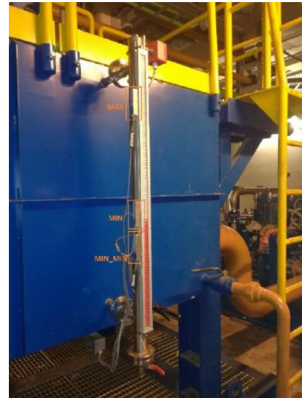
Slika 2.32. Mjerac razine ulja u industriji
