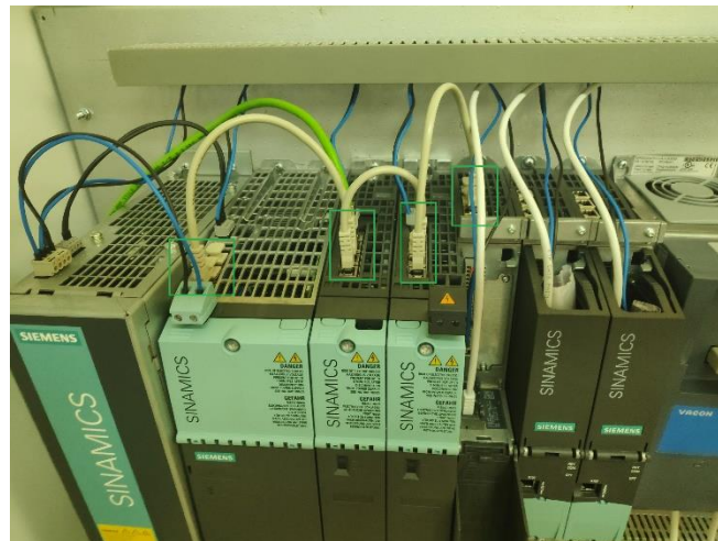
Slika P1.2 DRIVE-CLiQ sučelje frekvencijskog pretvarača
