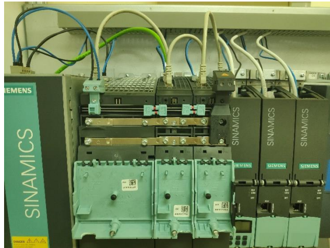
Slika P1.1 DC link frekvencijskog pretvarača
