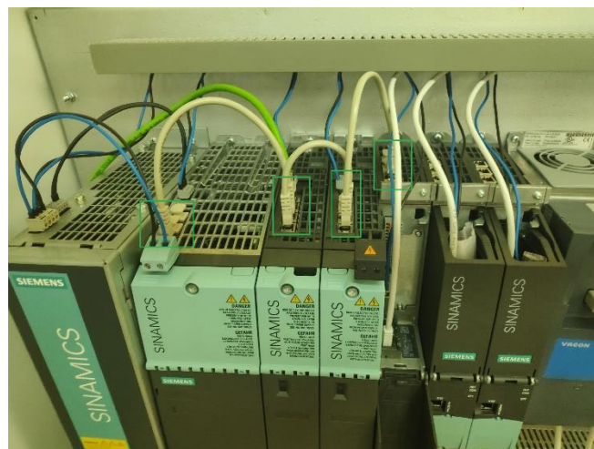
Slika P1.2 DRIVE-CLiQ sučelje frekvencijskog pretvarača
