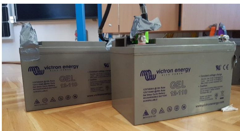
Slika 4.2. GEL baterije 12V, 110Ah
