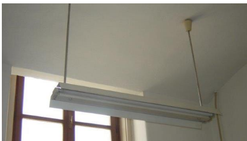
Slika 3.2. Trenutno stanje – rasvjeta u hodniku [19]
