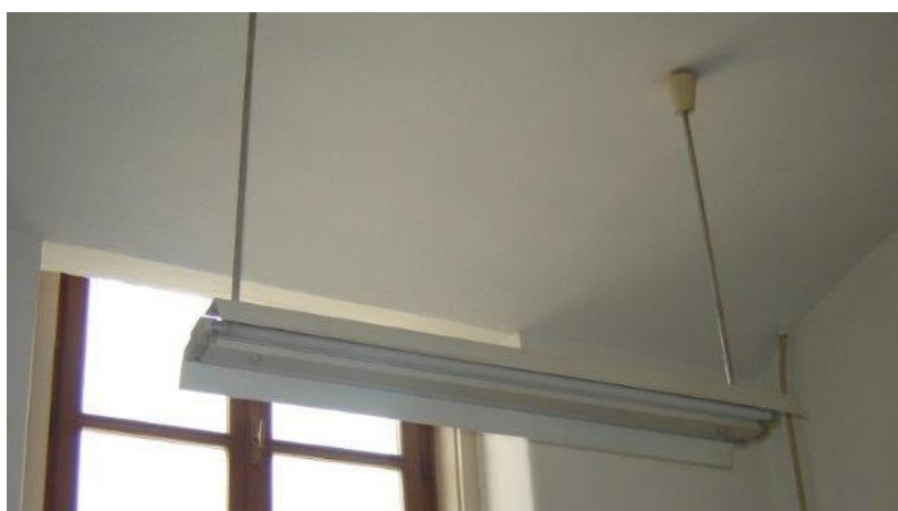
Slika 3.2. Trenutno stanje – rasvjeta u hodniku [19]
