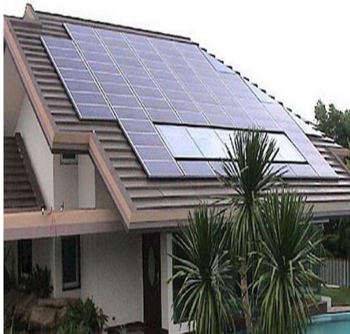
Slika 3.3. Solarni paneli na kući
