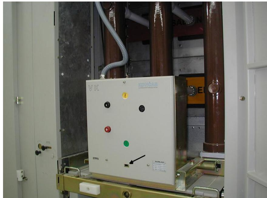
*Slika 5.1. Prikaz pogonskog mehanizma [12]*
