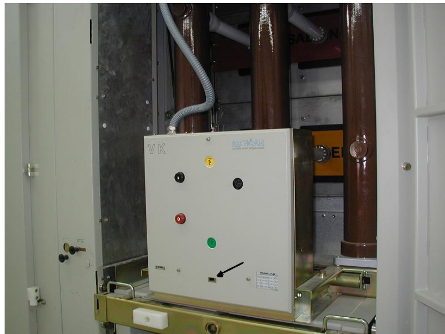
Slika 5.1. Prikaz pogonskog mehanizma [12]
