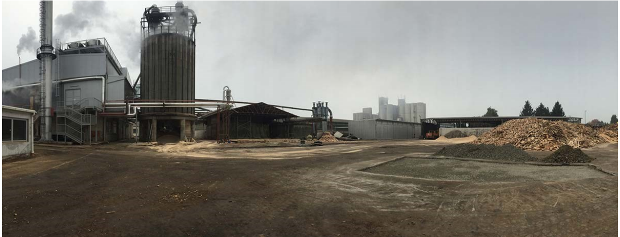
Slika 3.1. Skladište drvnog otpada i samo postrojenje
