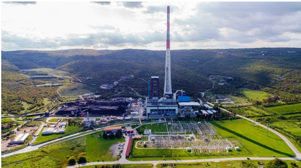
Slika 2.1. Vanjski izgled termoelektrane [2]
