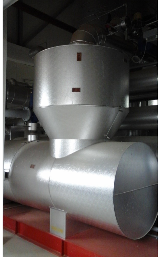
Slika 3.16. Ishlapljivač
