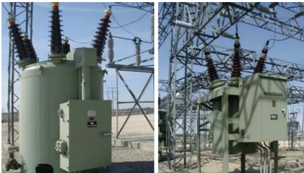
Sl.2.5. Uljni prekidači (lijevo-sa velikim sadržajem ulja, desno-malouljni)
