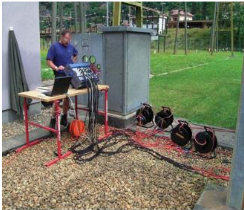
Sl.4.4. Prekidač spojen za ispitivanje
