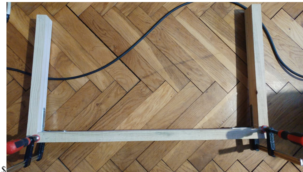
Slika 4.5. Učvršćivanje drvenog okvira
