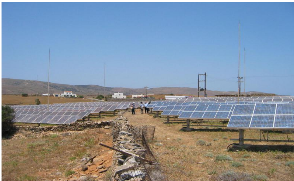
Slika 4.2. Prikaz fotonaponskih panela na otoku Kythnos [18]
