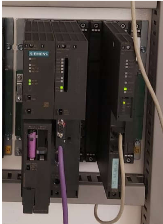
Sl. 5.3. Izgled PLC konfiguracije
