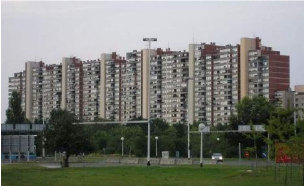
Slika 5.4 Zgrada Mamutica u Zagrebu [18]
