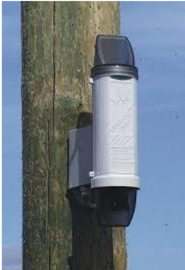
**Slika 5.** Indikator kvara LineTroll R400D [4]
