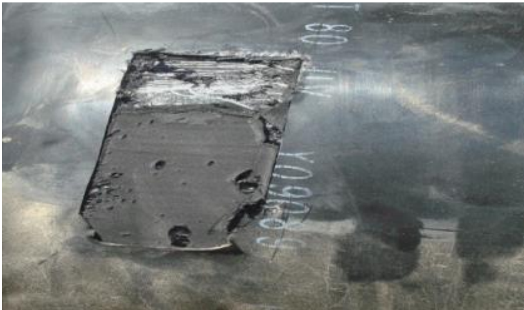
Slika 3.6. Mjehurići zraka premaza cjevovoda [11]
