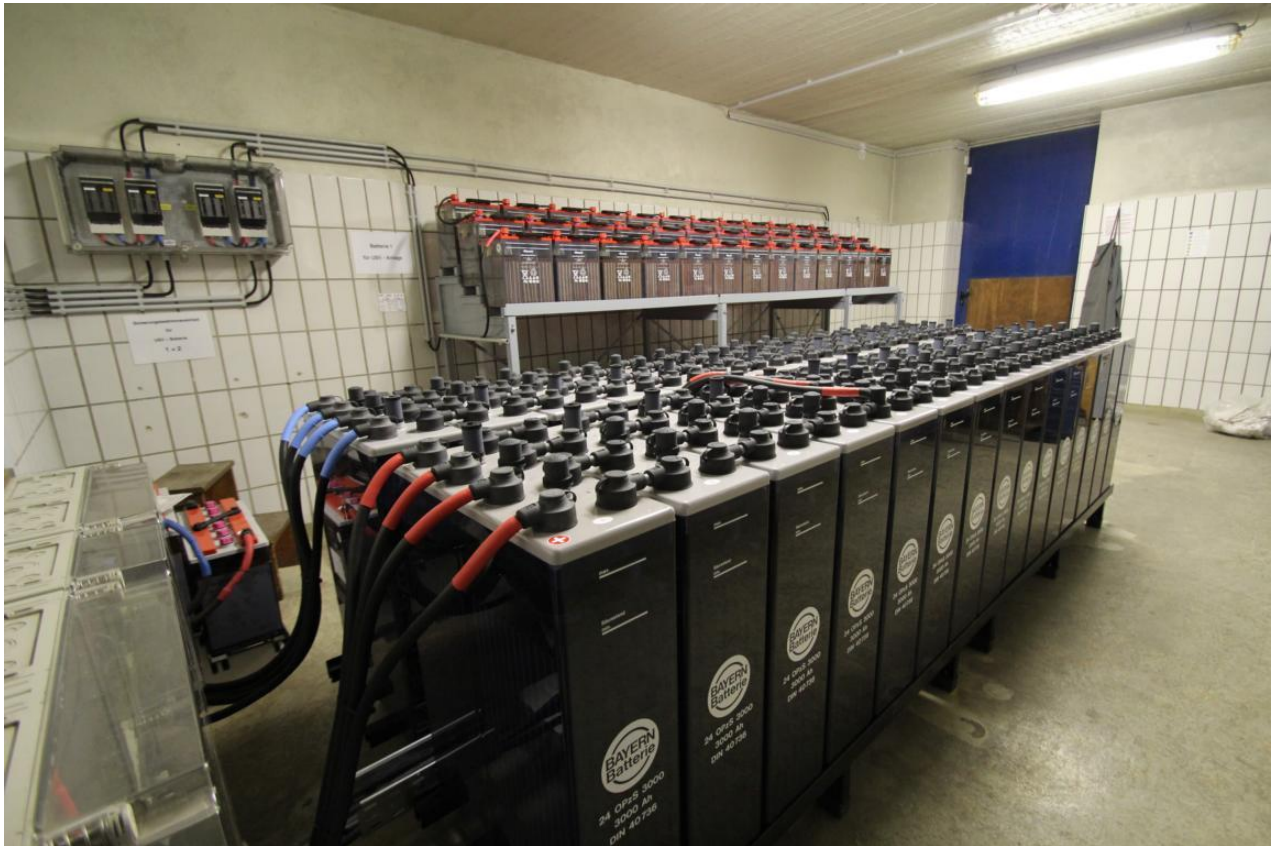
Slika 6.1. Klasične olovno kiselinske baterije [10]
