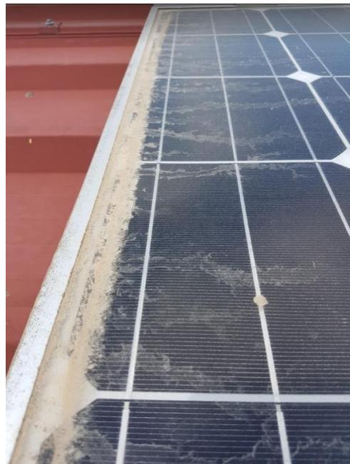
**Slika 5.10.** Donji rub panela sa akumuliranim slojem pijeska koji dovodi do zasjenjenja
