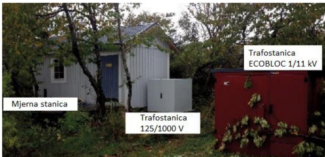
**Slika 3.4.** Mjerna stanica spojena na glavni mrežni transformator ECOBLOC (1/11 kV) kroz Hexaformer (0,125/1 kV) u Härmanöu u Lysekilu [1].
