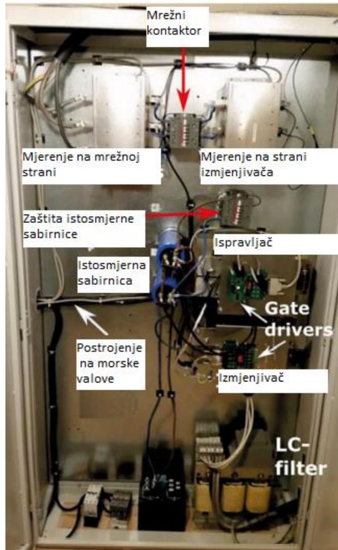
Slika 3.5. Električni sustav spojen s mrežom [1].
