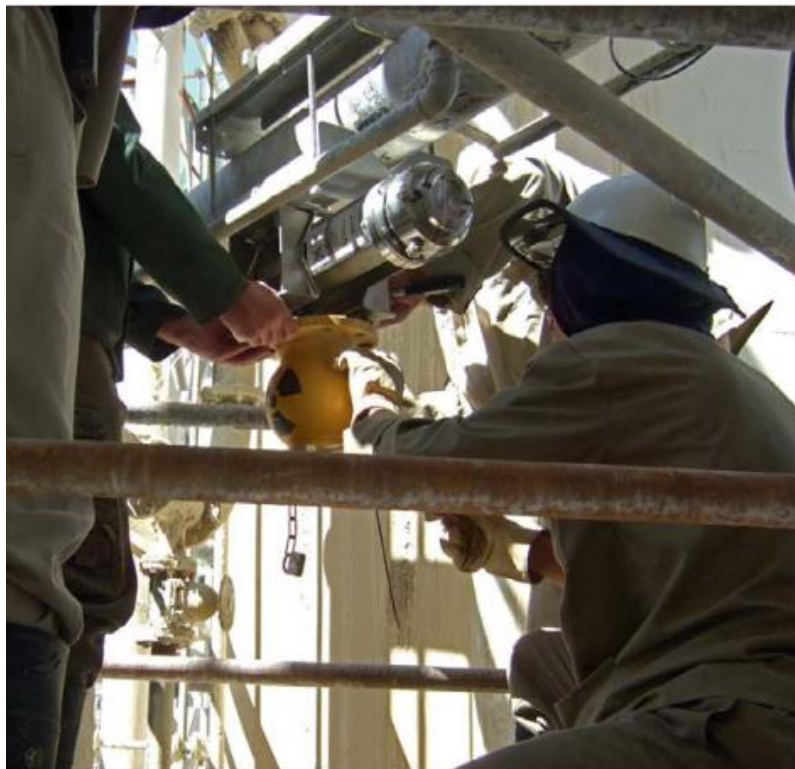
Slika 6.1. Postavljanje radiometrijskog uređaja[2]
