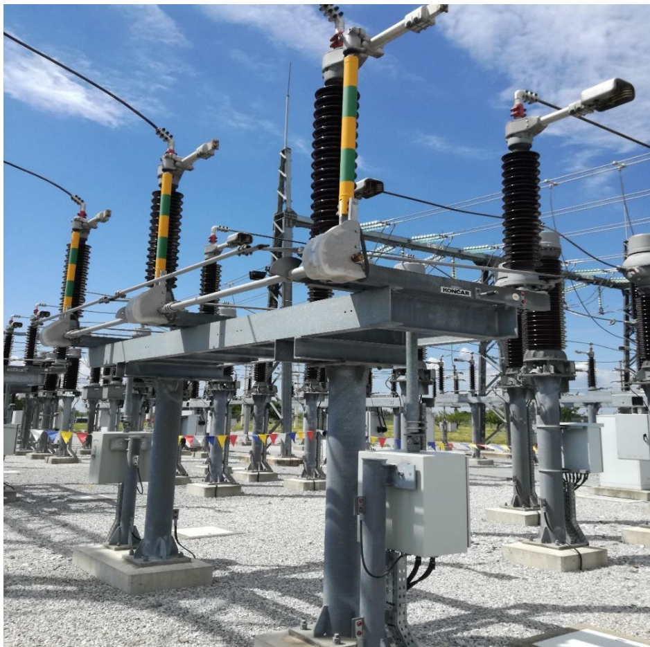
Slika 3.4. Dvostupni okretni rastavljači sa zemljospojnicima
