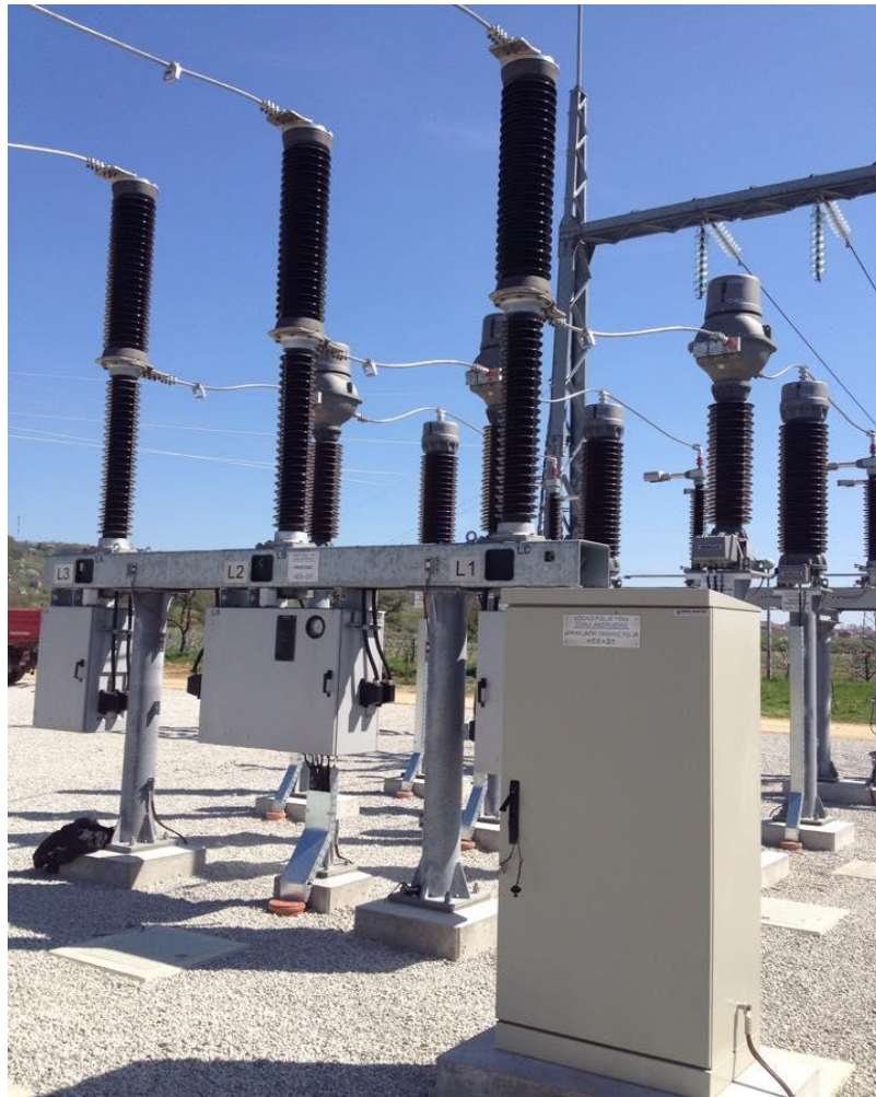
Slika 3.3. SF 6 prekidač u TS Sl. Brod 1, vodno polje Donji Andrijevi
