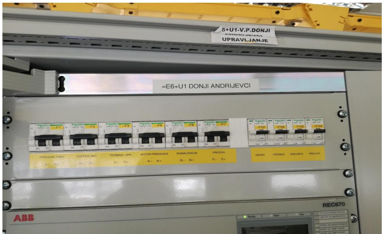
Slika 5.11. Istosmjerni i izmjenični automatski osigurači u ormaru upravljanja E6+U1
