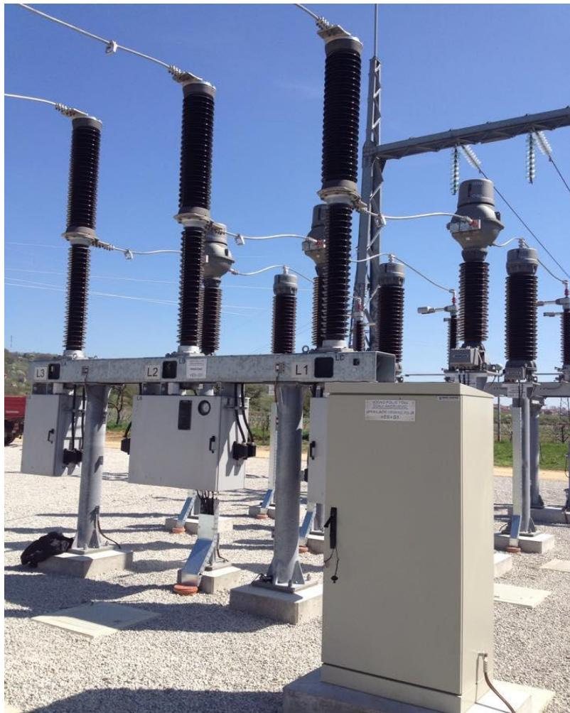
Slika 3.3. SF<sub>6</sub> prekidač u TS Sl. Brod 1, vodno polje Donji Andrijevci
