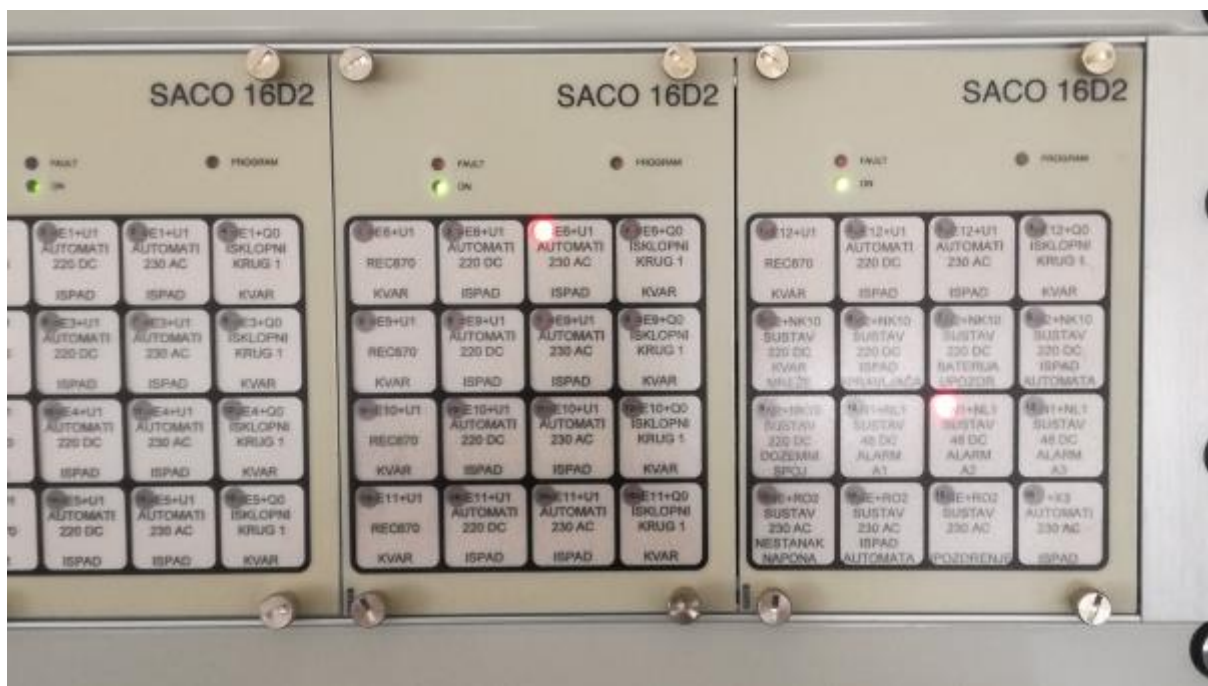
Slika 5.12. Signalizacijska dojavna jedinica
