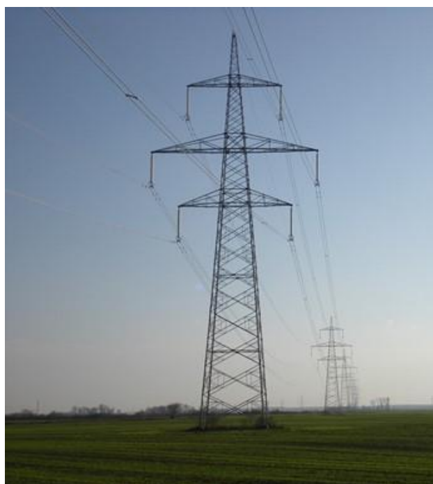
Slika 3.1. Stup dvosistenskog 400 kV dalekovoda [1]
