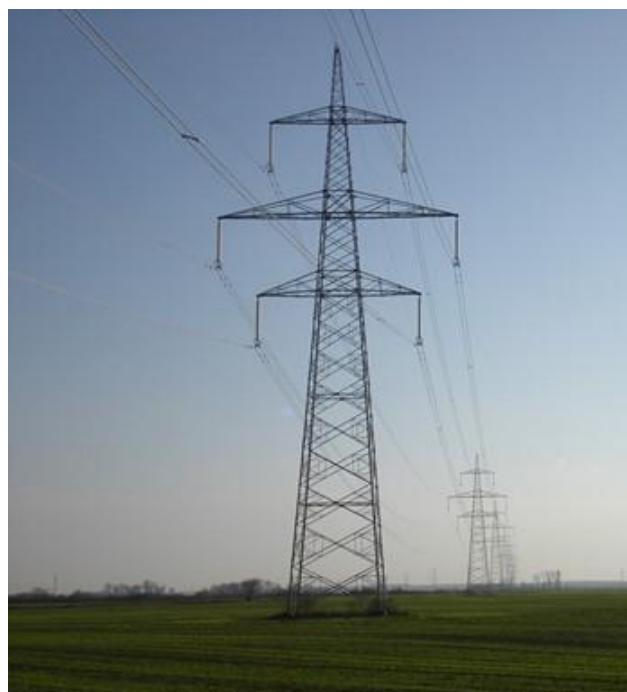
Slika 3.1. Stup dvosistemskog 400 kV dalekovoda [1]
