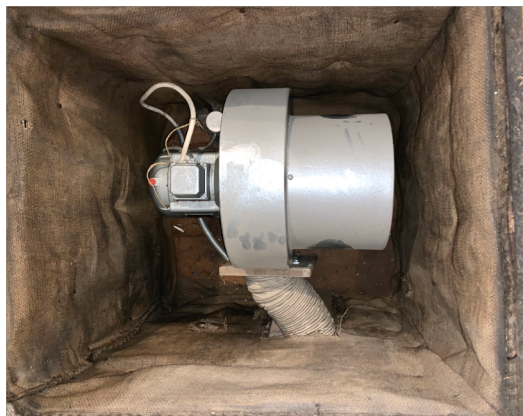
Slika P.1.4. Pogled na otklopljenu kutiju sustava dovoda zraka sa zvučnom izolacijom, kućištem elektromotora, izlaznom komorom i usisnom komorom
