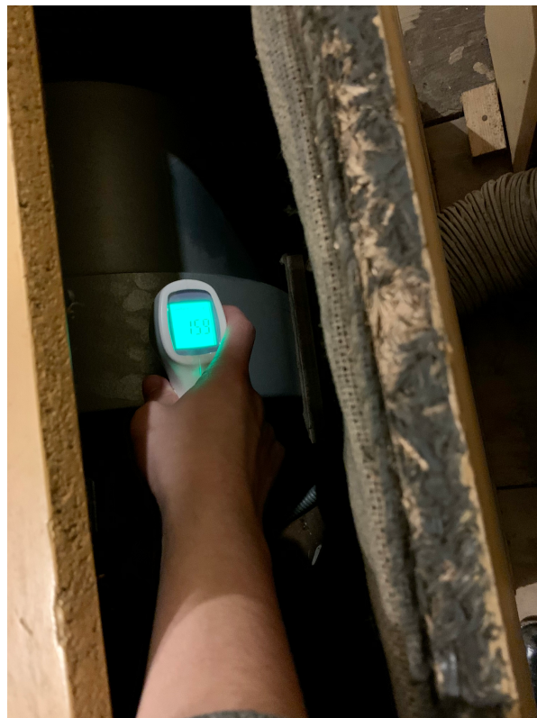
Slika 4.2. Mjerni postav za mjerenje temperature kućišta sustava dovoda zraka
