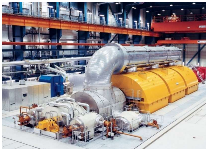
Slika 3.3 Siemens turbogenerator snage 500 MW, pokretan parnom turbinom [8]
