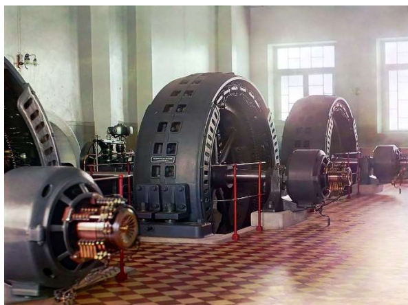
Slika 3.1 Električni generator u hidroelektrani [4]
