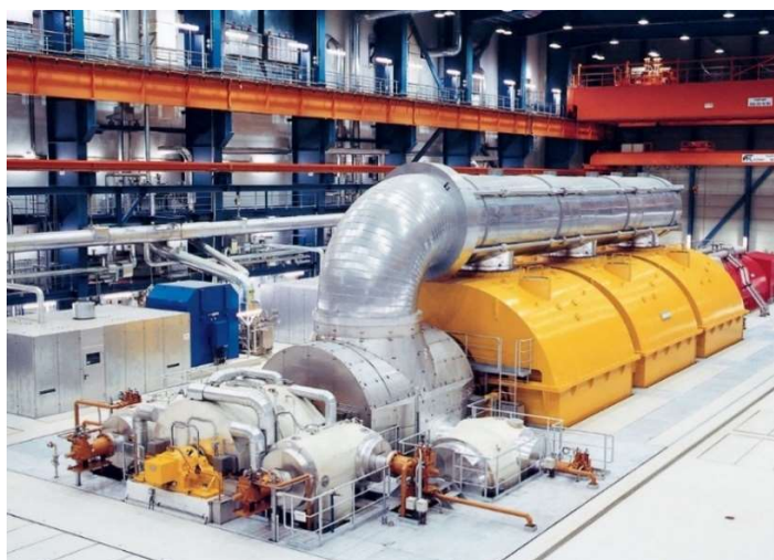
Slika 3.3 Siemens turbogenerator snage 500 MW, pokretan parnom turbinom [8]
