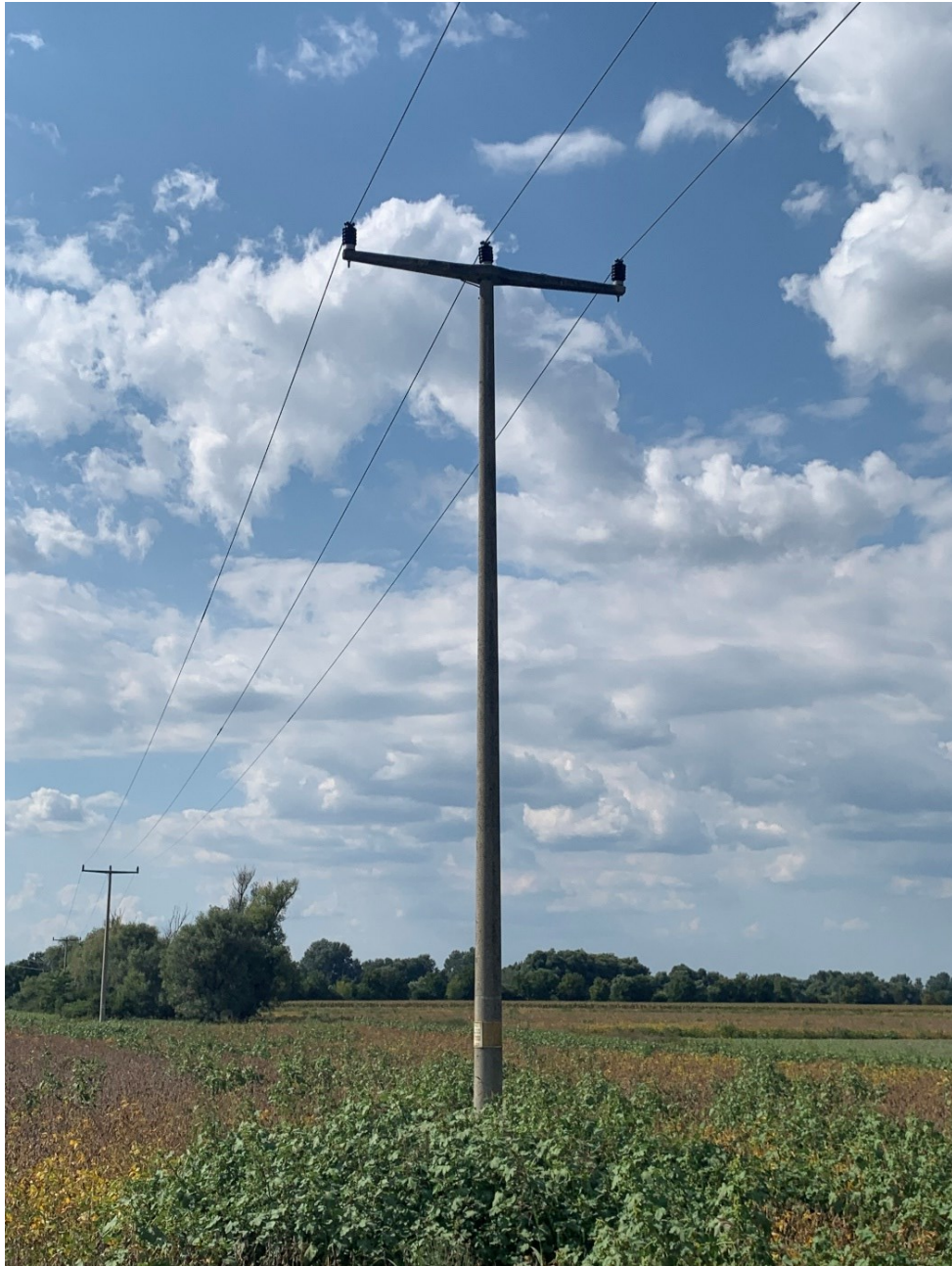
Slika 4.1. Prikaz 10 kV dalekovoda
