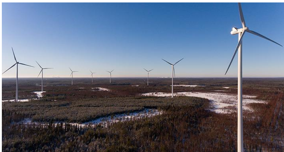
Sl. 5.3. Najveći kopneni Vestas vjetroagregat (V162-6.2 MW) [17]
