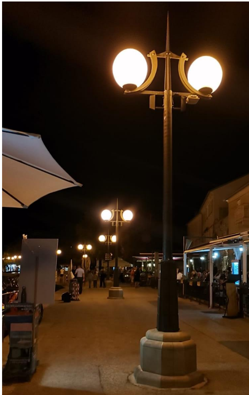
Slika 4.5. Vanjska rasvjeta na krčkoj rivi
