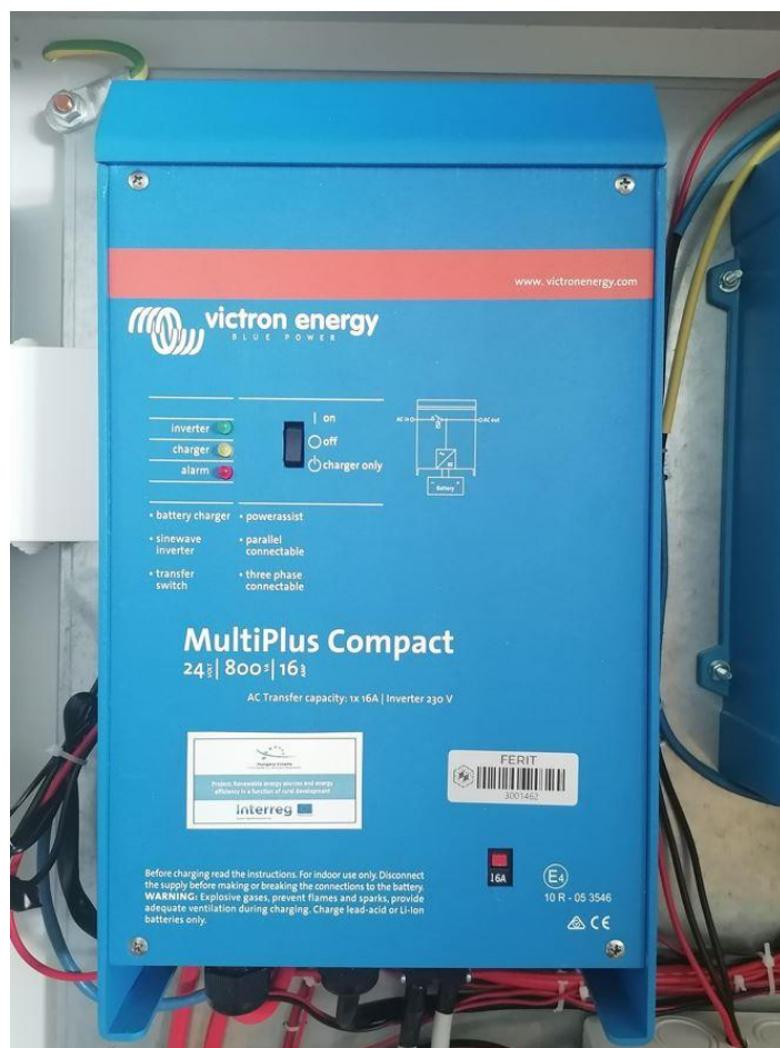
Slika 4-7 MultiPlus Compact 24 | 800 | 16 izmjenjivač/punjač
