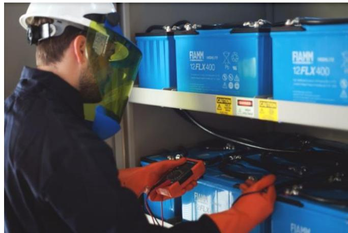
Slika 7.2. Mjerenje napona baterija za UPS [22]
