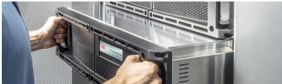
Slika 7.1. Izmjena bloka modularnog UPS-a proizvođača „ABB“ [20]
