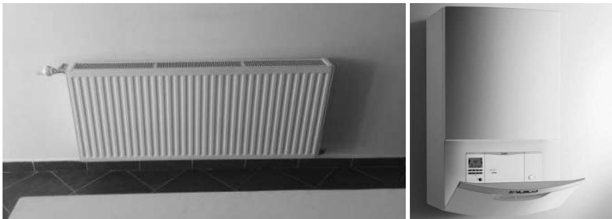
Slika 5.1: Aluminijski pločasti radijatori i fasadni kondenzacijski bojler [12]
