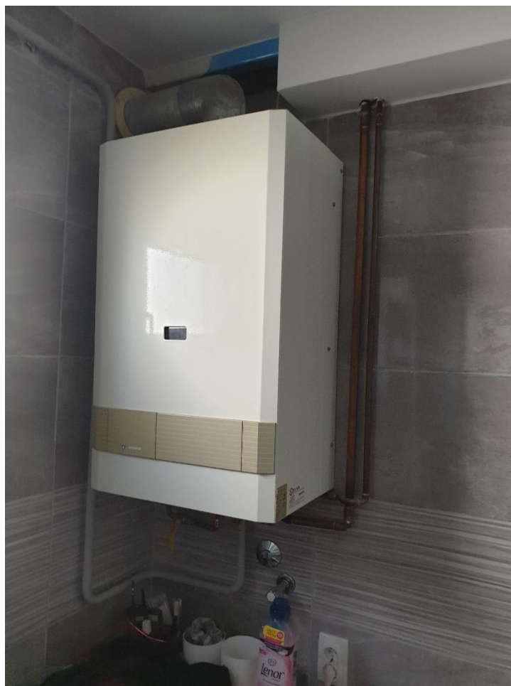
Slika 3.5. Plinski kombi bojler Junkers ZWE 24-2AE.
