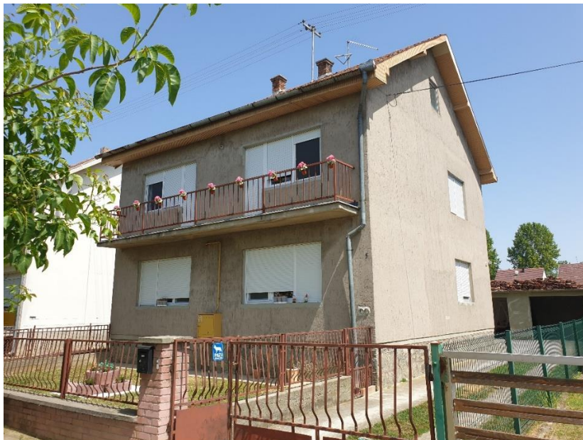
Slika 3.1. Južno i istočno pročelje obiteljske kuće.
