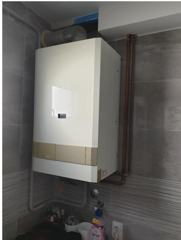
Slika 3.5. Plinski kombi bojler Junkers ZWE 24-2AE.
