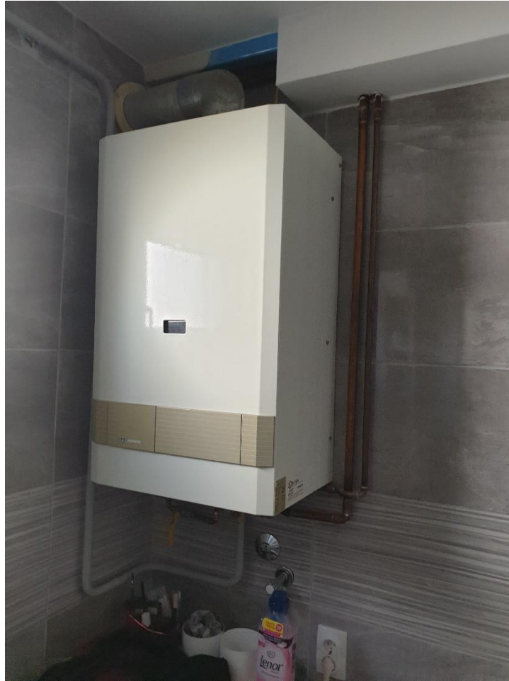
Slika 3.5. Plinski kombi bojler Junkers ZWE 24-2AE.
