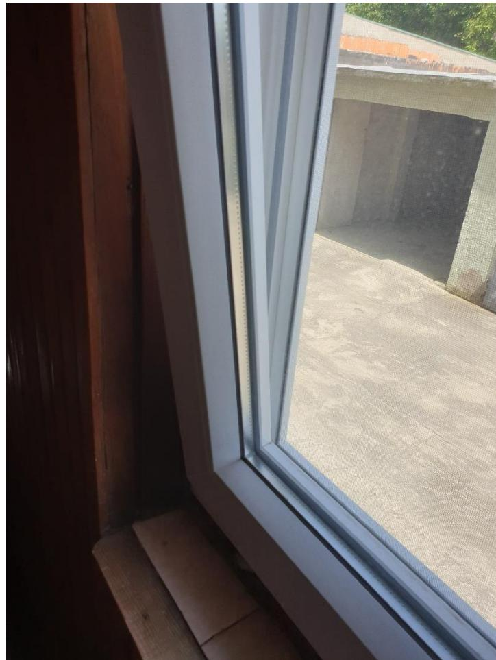
Slika 3.4. Profil prozora ukupne toplinske provodljivosti  $1,4 \text{ W/m}^2\text{K}$ .
