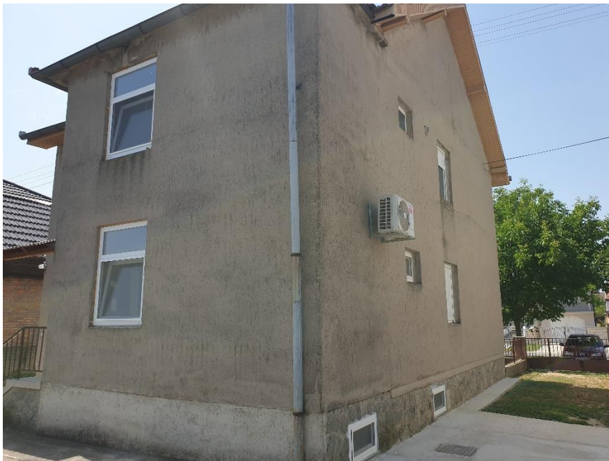
Slika 3.3. Sjeverno i zapadno pročelje obiteljske kuće.
