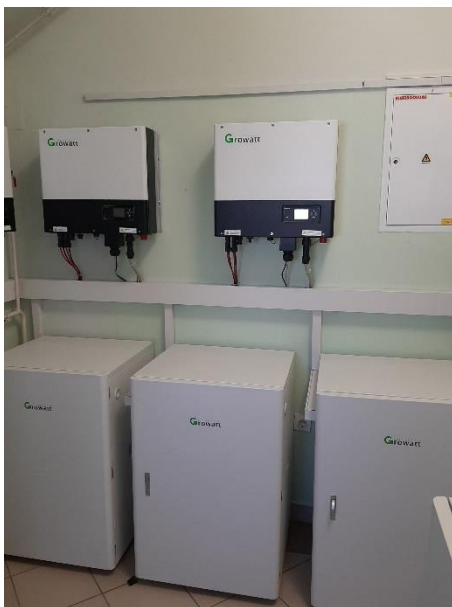
Slika 3.11. Primjer sustava s pohranom električne energije
