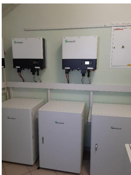
Slika 3.12. Hibridni izmjenjivači s pohranom
