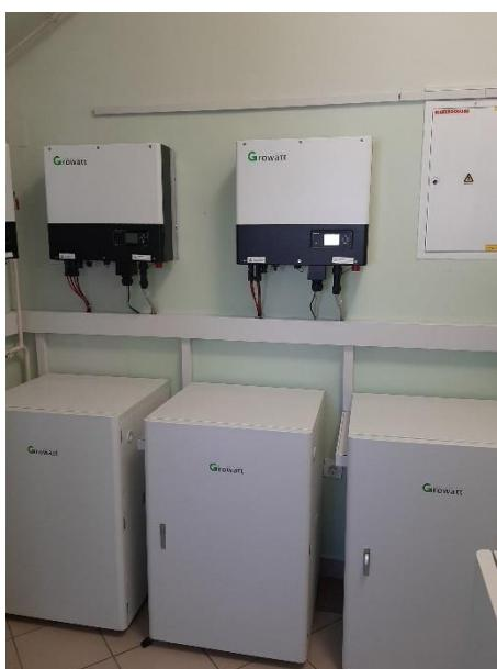
*Slika 3.12. Hibridni izmjenjivači s pohranom*
