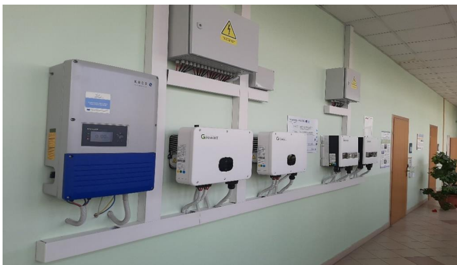
Slika 1.3. Izmjenjivači u mikromreži FERIT 1
