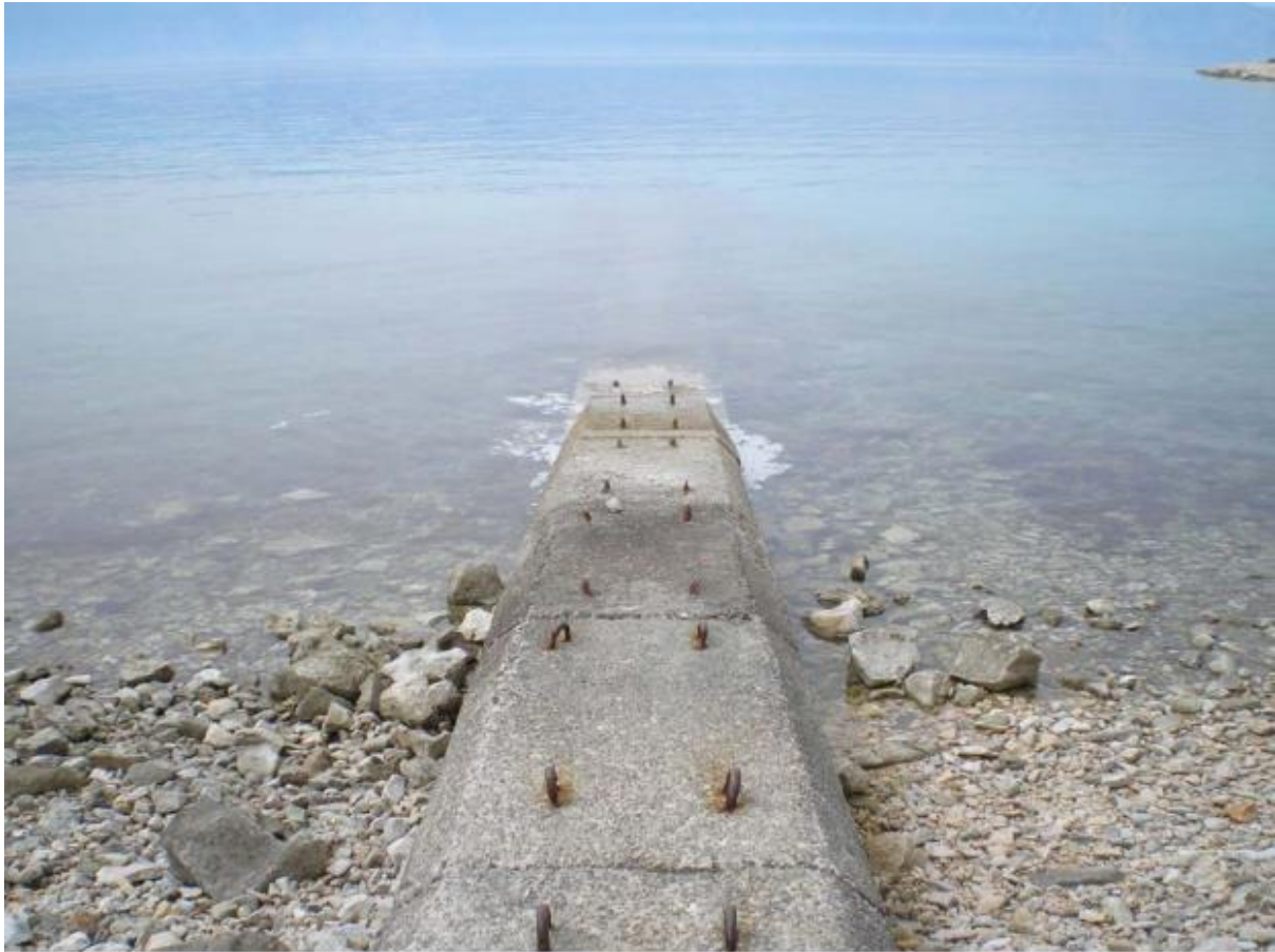
Slika 3.14. Priobalna zaštita 110 kV podmorskog kabela [11]
