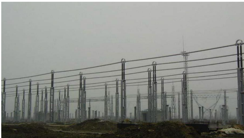
Slika 2.1. Cijevni vodiči [1]
