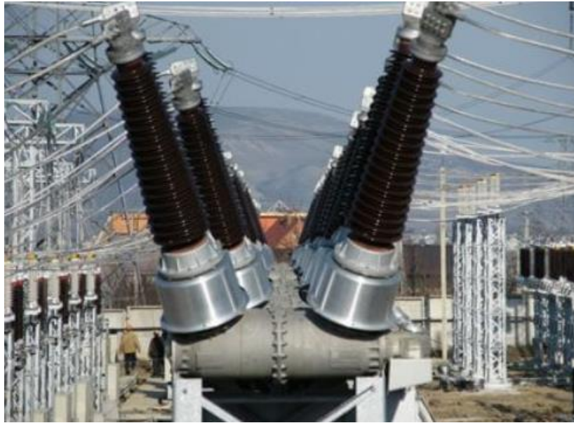
Slika 2.17. SF 6 prekidač [16]
