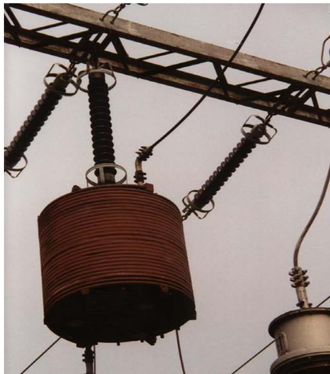
Slika 2.29. Visokofrekvencijske prigušnice [1]
