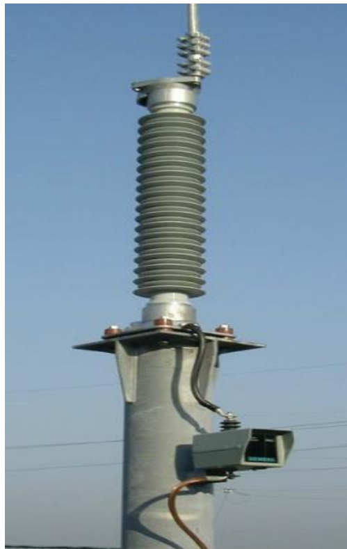
Slika 2.23. Cink oksidni (ZnO) odvodnik prenapona [1]
