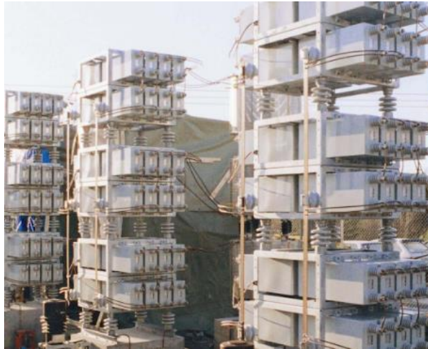
Slika 2.31. Kondenzatori [1]
