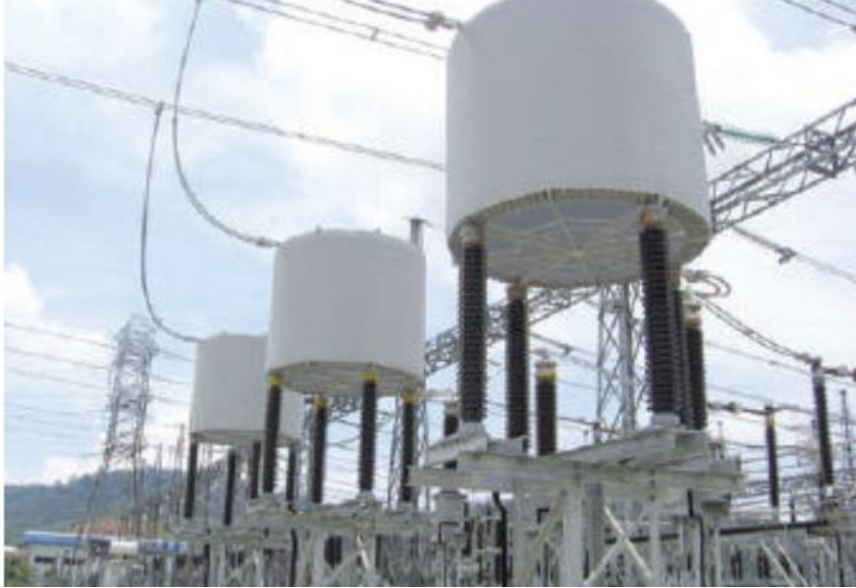
Slika 2.28. Prigušnice za ograničenje kratkog spoja [6]
