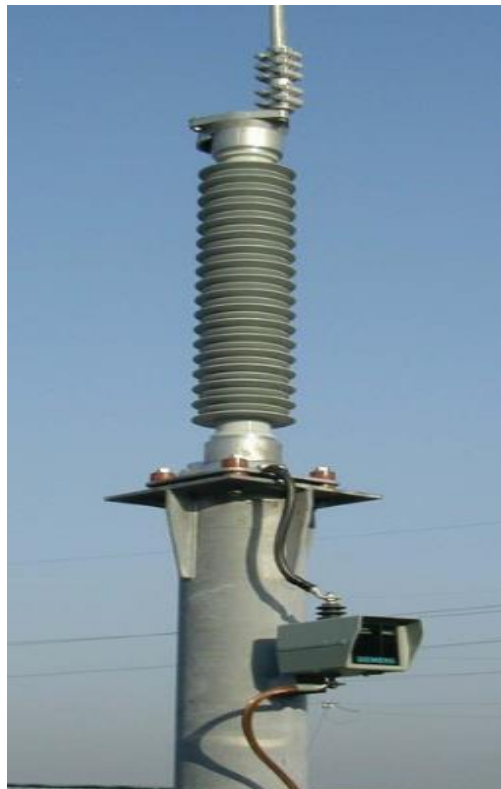
Slika 2.23. Cink oksidni (ZnO) odvodnik prenapona [1]
