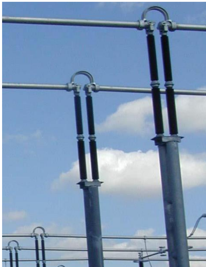
Slika 2.4. Potporni izolator 400 kV [1]
