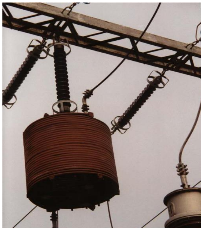
Slika 2.29. Visokofrekvencijske prigušnice [1]
