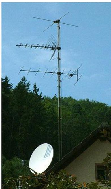
*Slika 7. Semi-direkcijska antenna [8]*
